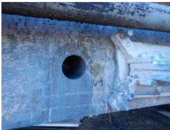
Obr.5.1-1: Pravý bok NK ve 2. mostním poli (2.MP) cca uprostřed rozpětí, odběrné místo vzorku betonu V1.
