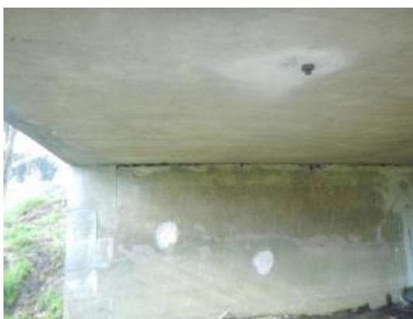
Obr. 5.4-9: Umístění nalepeného zkušebního terče T4 na podhledu mostovky před Op3 vlevo.
