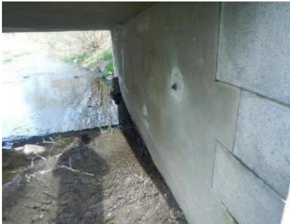
Obr. 5.4-1: Umístění nalepeného zkušebního terče T1 na čele díku Op1.
