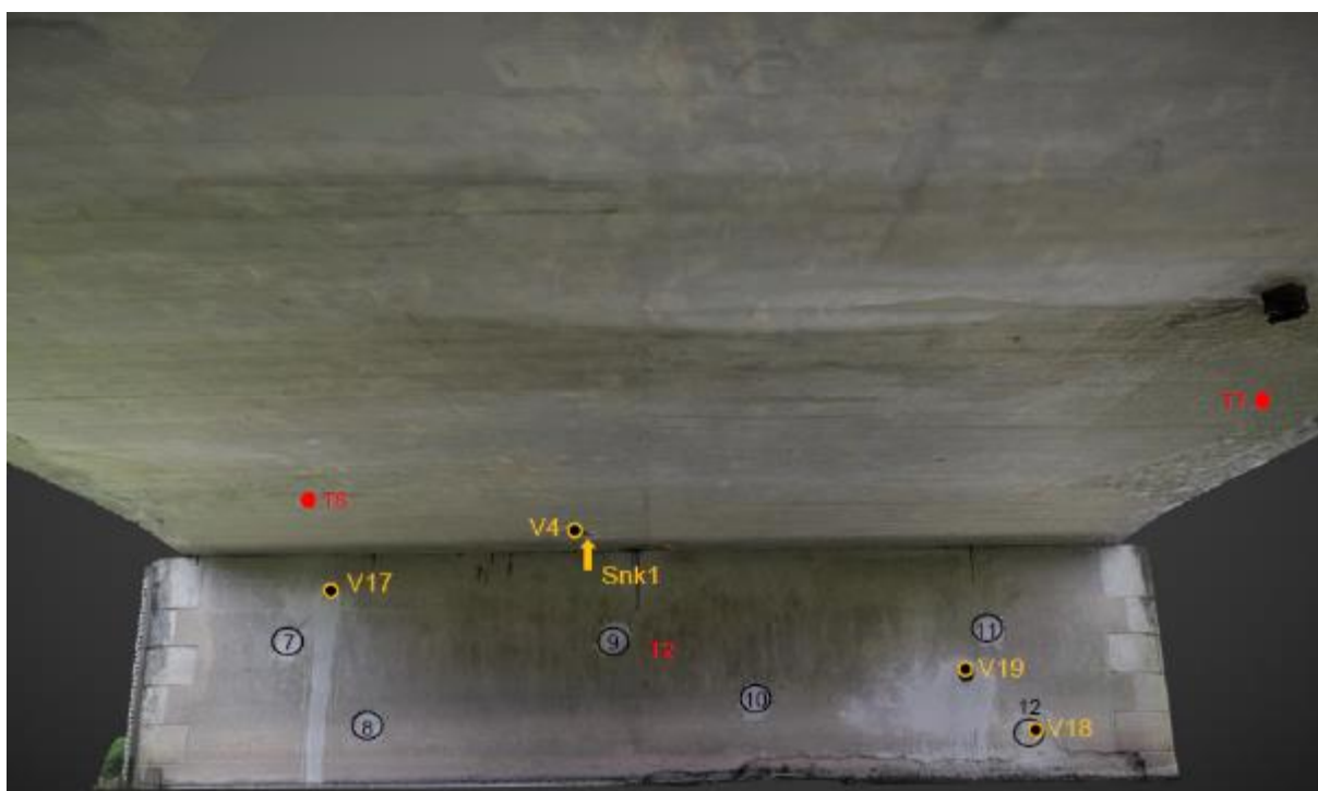
Obr. 5-3: Rozmístění odběrných míst vzorků a zkoušek betonu na P2 a pohledu NK.
