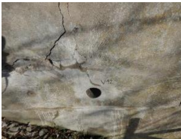
Obr.5.1-23: Pravé křídlo Op1, odběrné místo vzorku betonu V12.
