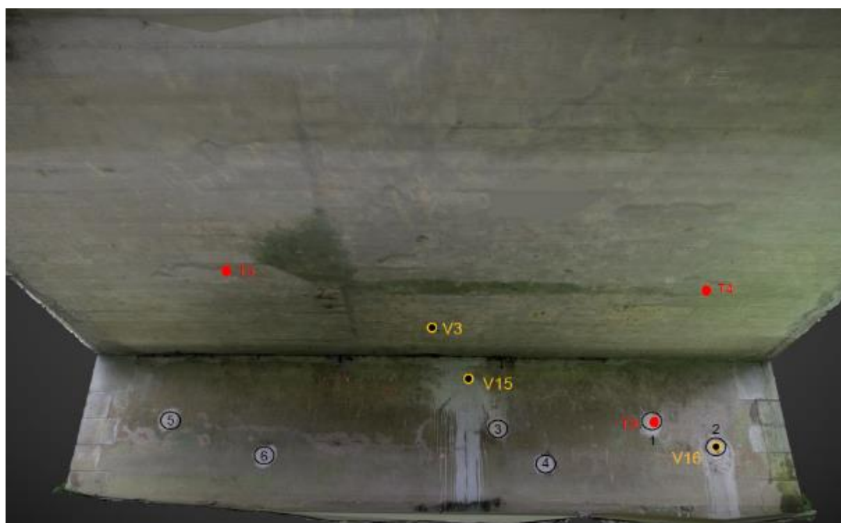
Obr. 5-5: Rozmístění odběrných míst vzorků betonu na Op3 a podhledu NK.
