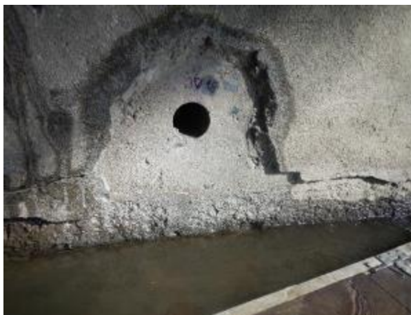
Obr.5.1-35: Levá strana P2 cca 0,4 m nad hladinou, odběrné místo vzorku betonu V18.
