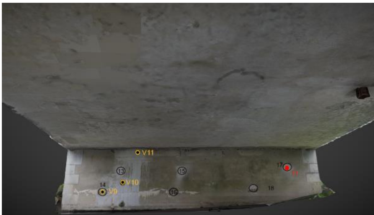
Obr. 5-1: Rozmístění odběrných míst vzorků a zkoušek betonu na Op1.
