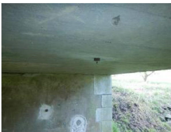
Obr. 5.4-7: Umístění nalepeného zkušebního terče T4 na podhledu mostovky před Op3 vpravo.
