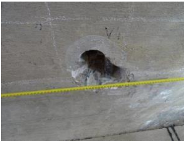
Obr. 5.3-1: Podhled NK před P2 uprostřed. Měření rozmístění podélné výztuže v místě sondy Snk1.
