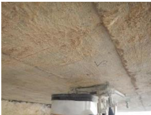
Obr.5.1-5: Podhled NK ve 2.MP před Op3 blíže jejímu středu, odběrné místo vzorku betonu V3.
