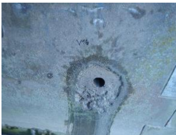
Obr.5.1-31: Pravá strana Op3, dběrné místo vzorku betonu V16.
