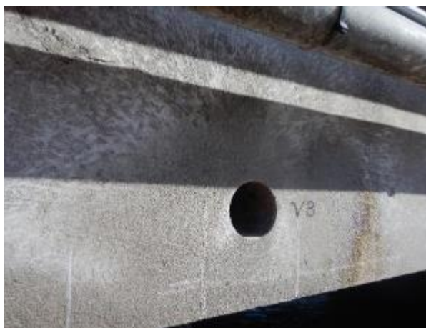
Obr.5.1-15: Pravý bok NK v 1.MP před Op1, odběrné místo vzorku betonu V8.
