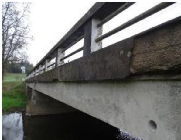
Obr.5.1-13: Levý bok NK v 1.MP před Op1, odběrné místo vzorku betonu V7.
