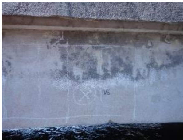
Obr.5.1-11: Levý bok NK v 1.MP cca uprostřed rozpětí, odběrné místo vzorku betonu V6.
