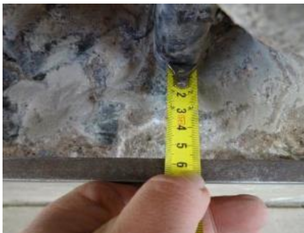
Obr. 5.3-5: Změřená tloušťka krycí vrstvy podél výztuže v místě sondy Snk1.
