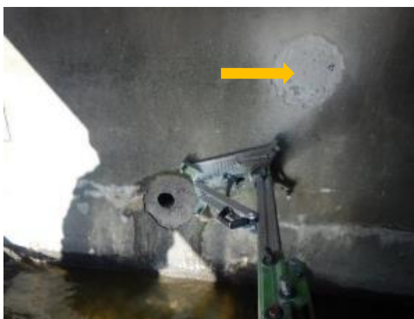
Obr.5.1-19: Pravá strana Op1 cca 1,0 m nad hladinou, odběrné místo vzorku betonu V10 (ø 150 mm).
