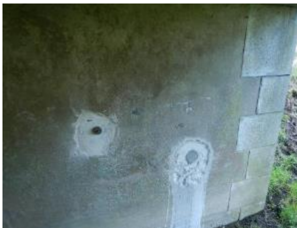
Obr. 5.4-5: Umístění nalepeného zkušebního terče T3 na pravé straně Op3.
