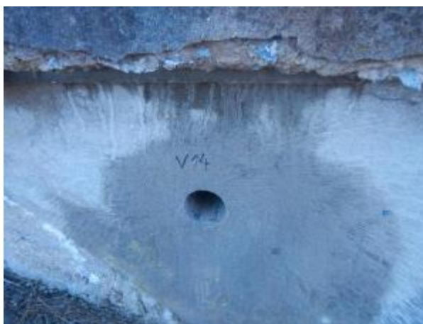
Obr.5.1-27: Levé křídlo Op3, odběrné místo vzorku betonu V14.
