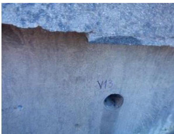
Obr.5.1-25: Levé křídlo Op1, odběrné místo vzorku betonu V13.
