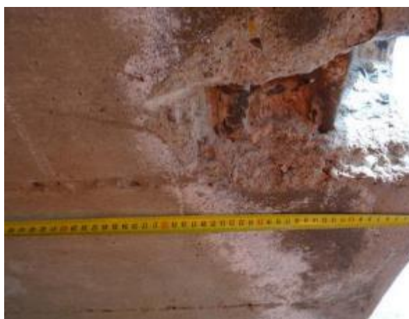
Obr. 5.3-8: Měření rozmístění podélné výztuže.
