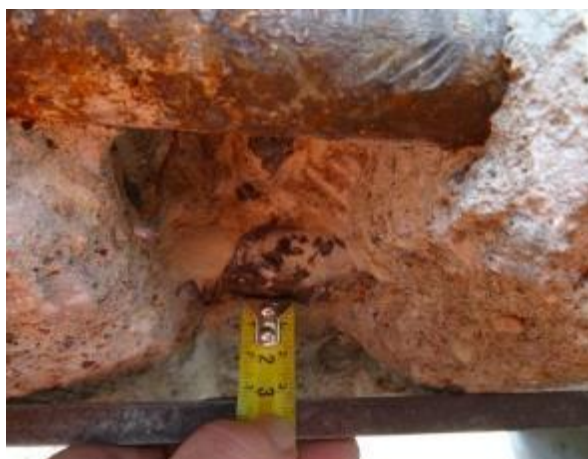
Obr. 5.3-10: Změřená tloušťka krycí vrstvy 2. prutu zleva podélné výztuže v místě sondy Snk2.
