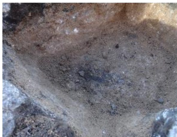
Obr.: 5.9-6: Kopaná sonda Sv2 v kamen. dlažbě na mostě do hloubky k izolaci mostovky.
