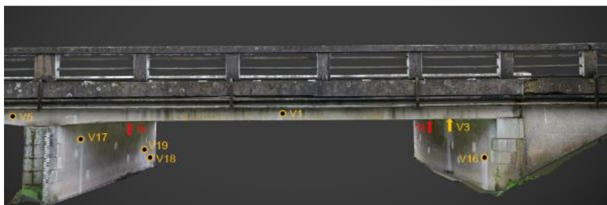
Obr. 5-4: Rozmístění odběrných míst vzorků betonu v 2. mostním poli v bočních pohledech. Nahoře levostranný pohled, dole pravostranný pohled.
