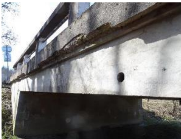
Obr.5.1-3: Levý bok NK ve 2.MP cca uprostřed rozpětí, odběrné místo vzorku betonu V2.
