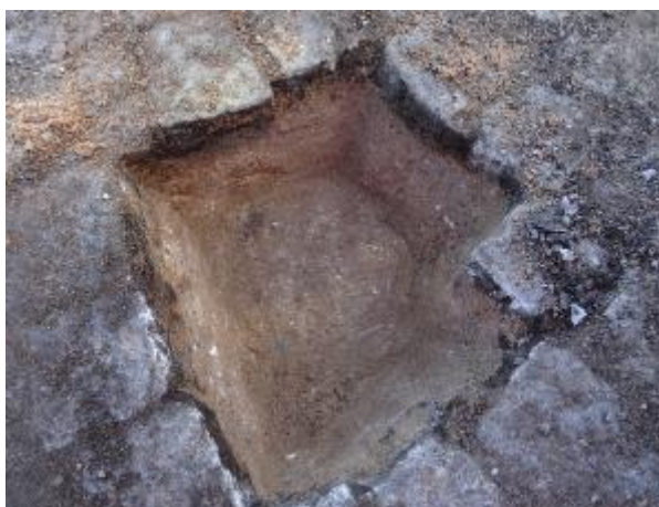
Obr.: 5.9-5: Kopaná sonda Sv2 v kamen. dlažbě na mostě do hloubky povrchu ochrany izolace z cement omítky.
