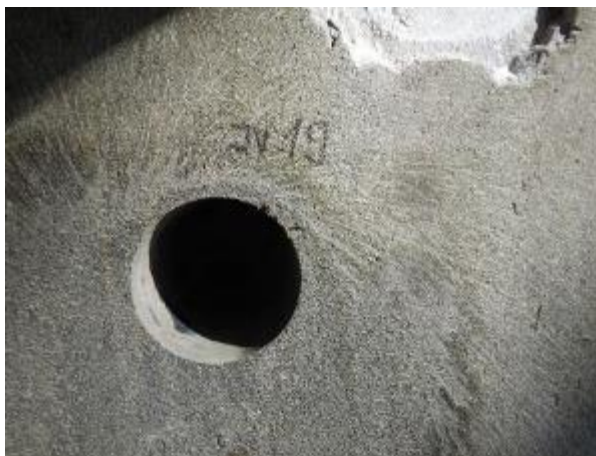
Obr.5.1-37: Levá strana P2 cca 1,0 m nad hladinou, odběrné místo vzorku betonu V 19 (ø 150 mm).
