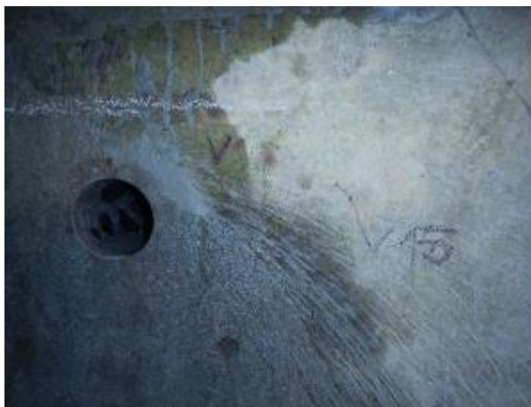
Obr.5.1-29: Úlož práh Op3 uprostřed, odběrné místo vzorku betonu V15.
