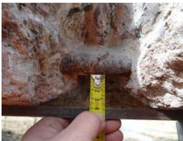
Obr. 5.3-9: Změřená tloušťka krycí vrstvy 1. prutu zleva podélné výztuže v místě sondy Snk2.
