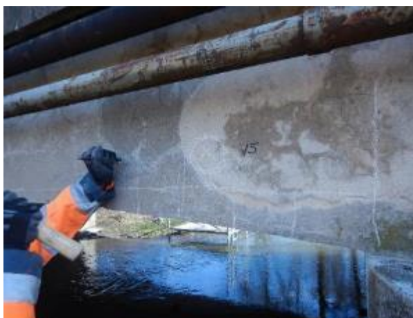
Obr.5.1-9: Pravý bok NK v 1. mostním poli (1.MP) před P2, odběrné místo vzorku betonu V5.
