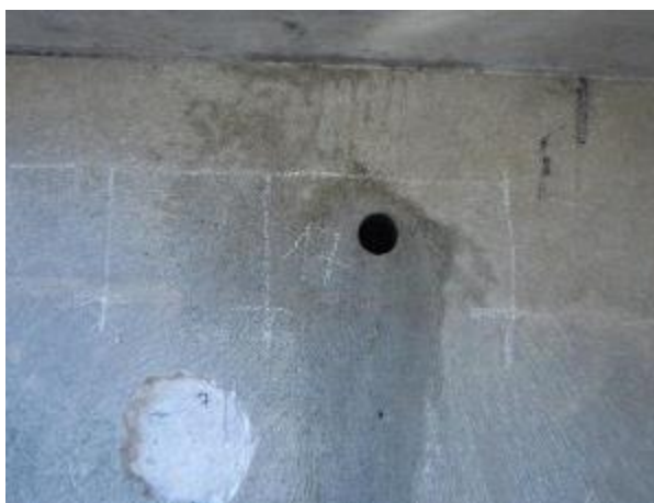
Obr.5.1-33: 1. Úlož práh P2 vpravo, odběrné místo vzorku betonu V17.
